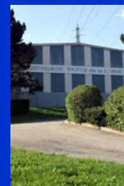
Puits de la Loire
